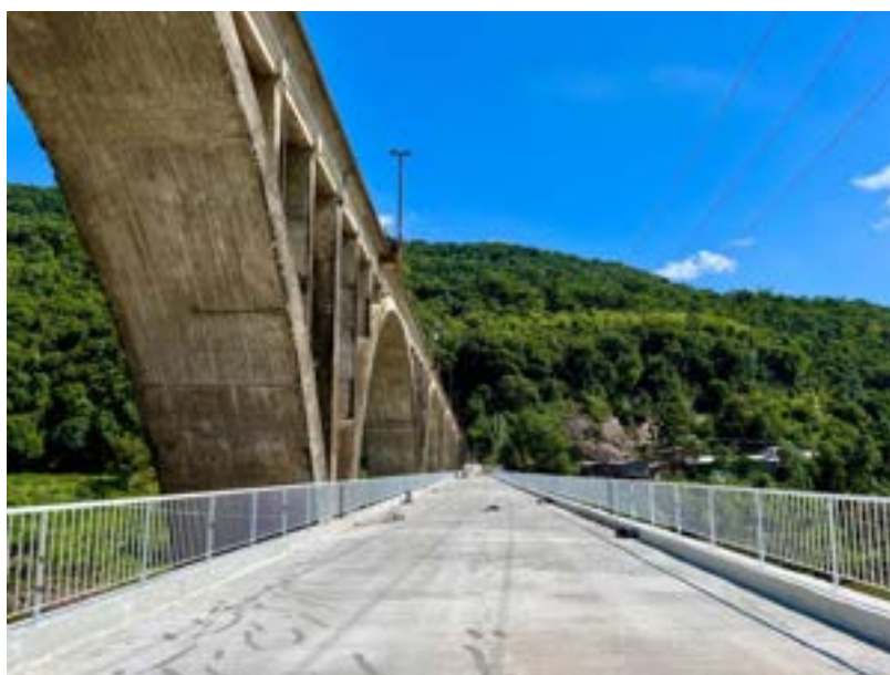
Figura 130: Ponte Rodoferroviária Brochado da Rocha.
