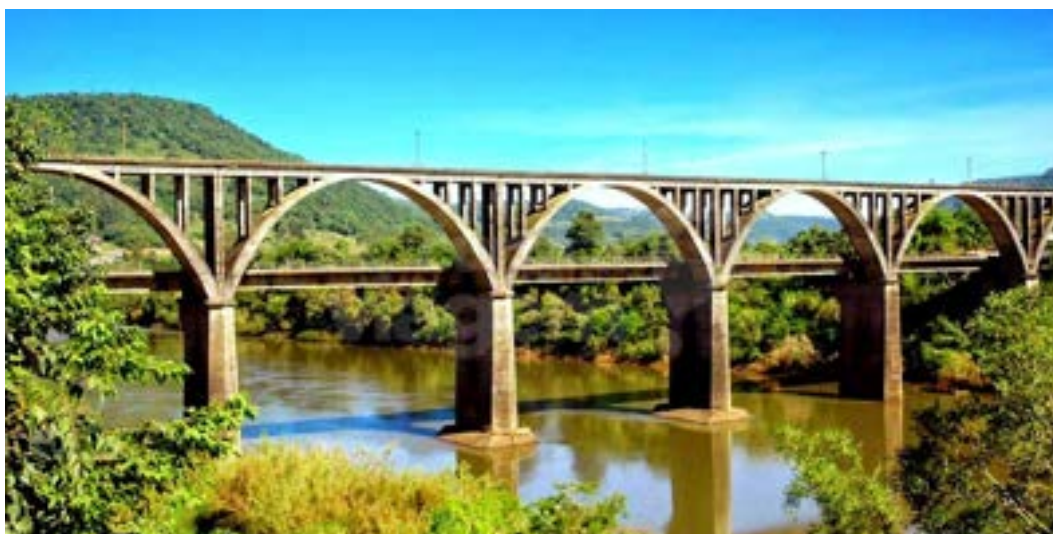
Figura 96: Ponte Rodoferroviária Brochado da Rocha.
