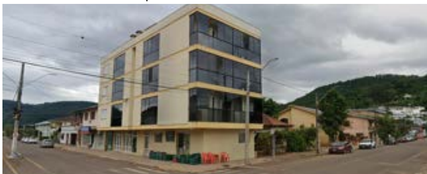
Figura 166: Quadra 1 - Vista da Esq. da Avenida Fernando Ferrari com a Rua Júlio de Castilhos.
