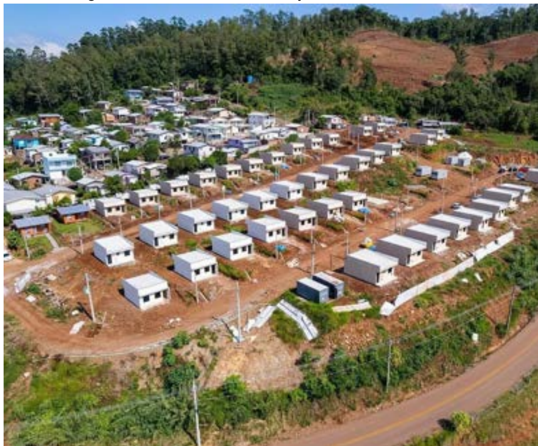
Figura 228: 50 moradias em construção no Jardim Cidade Alta 2.
