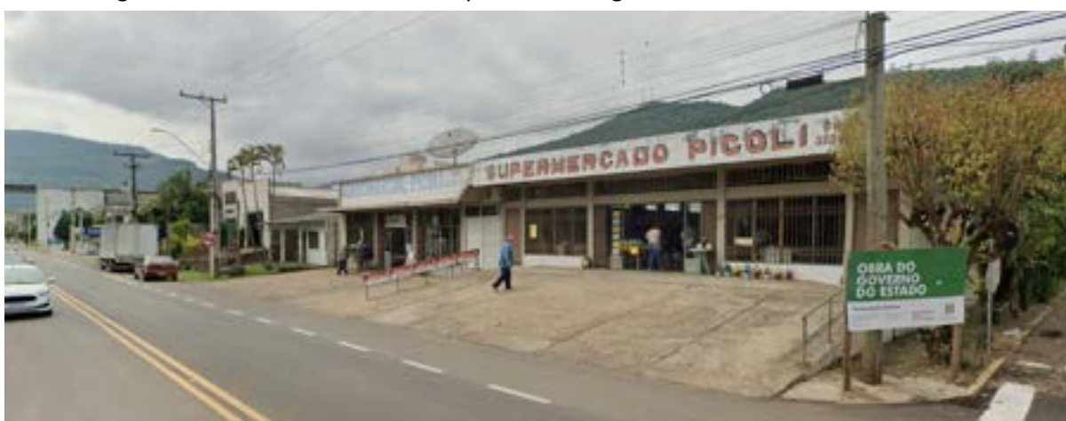
Figura 168: Quadra 2 - Vista da Esq. Avenida Borges de Medeiros e Rua João Picolli.
