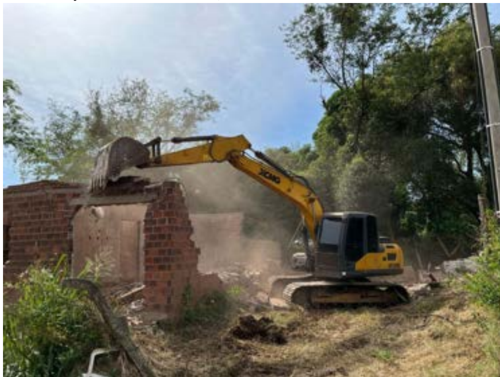
Figura 230: Remoção das casas destruídas, condenadas e localizadas em áreas de risco extremo.
