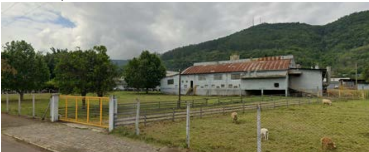
Figura 173: Quadra 3 - Vista da Avenida Fernando Ferrari, sentido leste.
