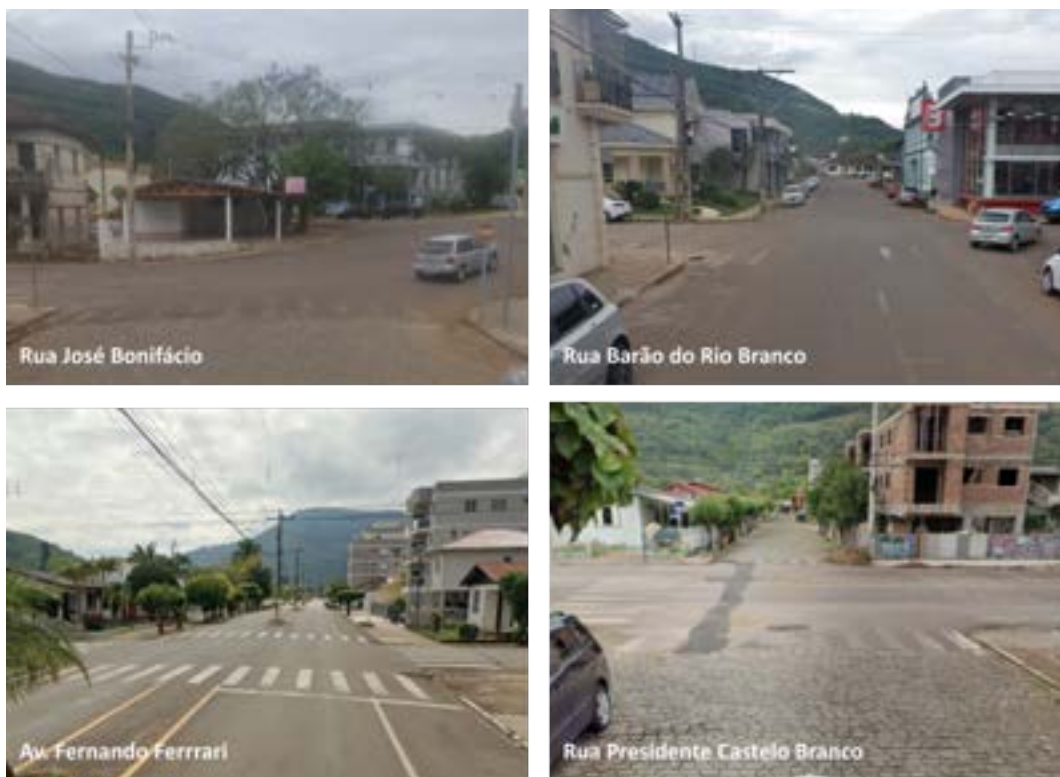
Figura 265: Condições atuais das travessias de pedestres da área da sede municipal.
