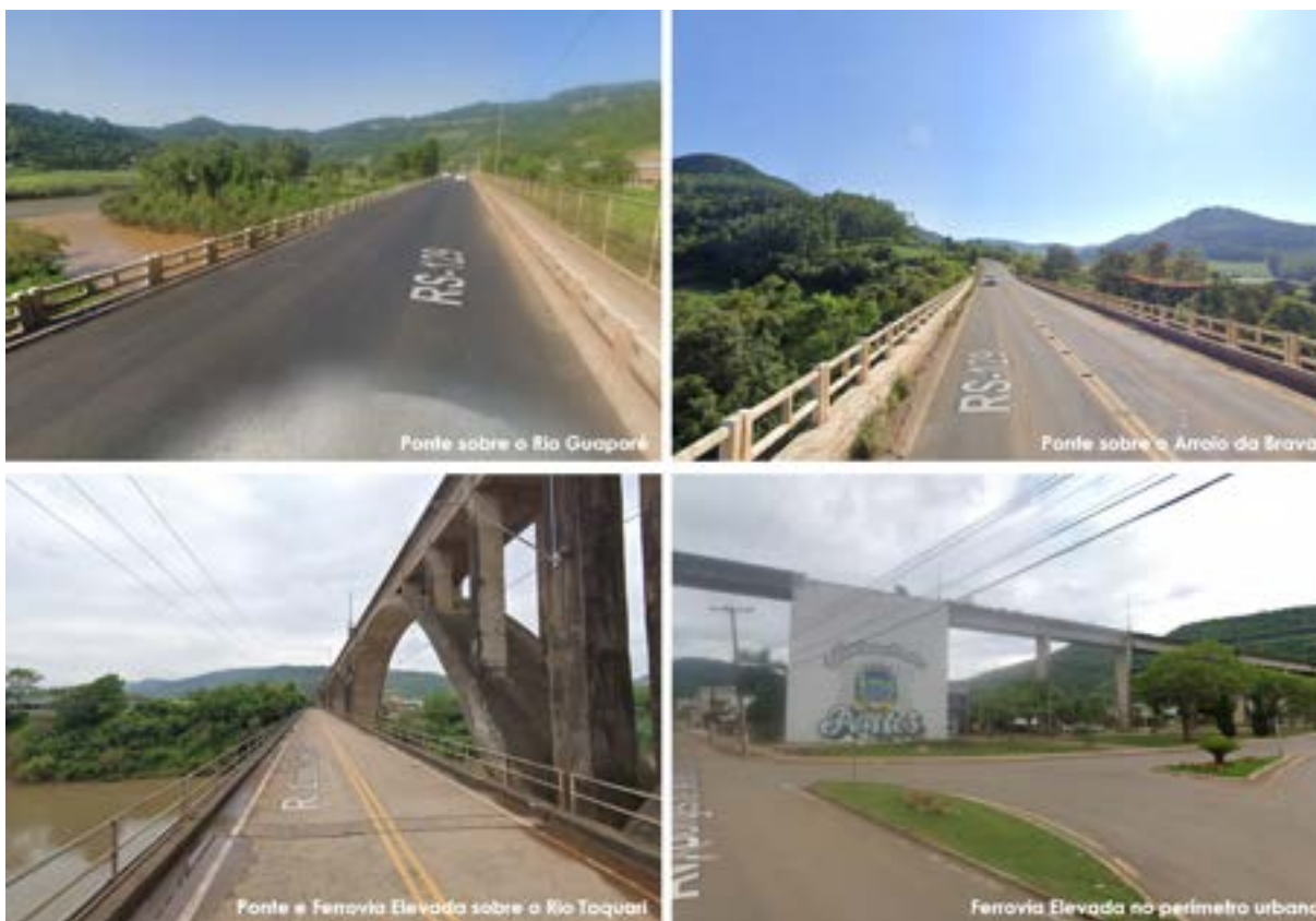
Figura 257: Pontes e Ferrovia Elevada no município de Muçum.
