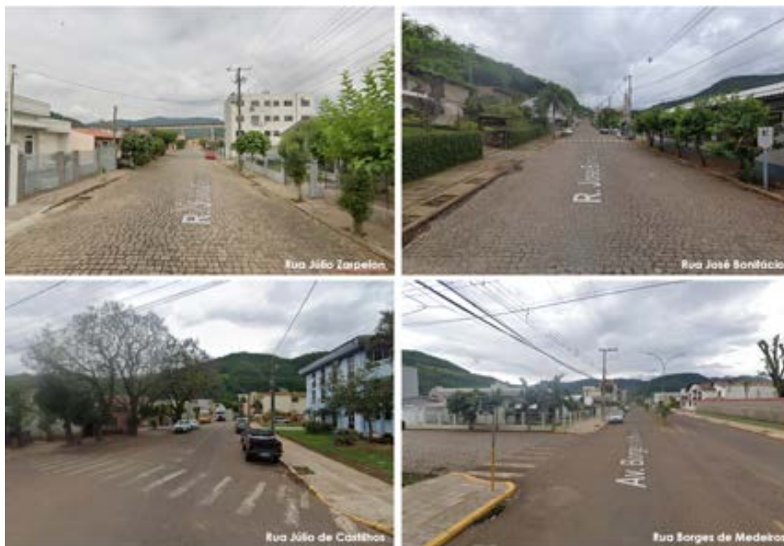
Figura 256: Pavimentação de ruas da área da sede municipal.
