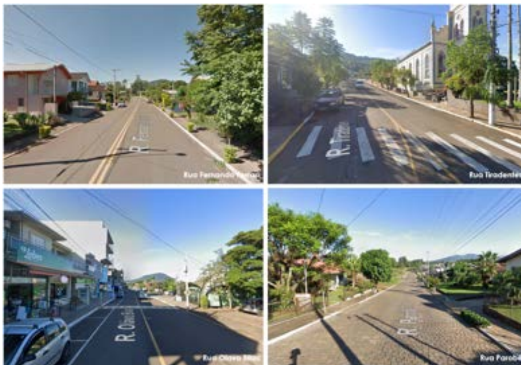
Figura 246: Pavimentação de ruas da área da sede municipal.
