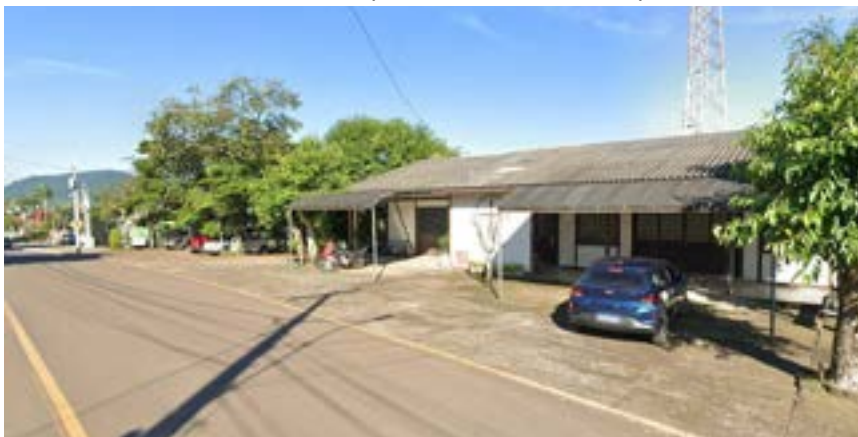
Figura 178: Quadra 2 - Vista da Capela Mortuária Municipal na Rua Olavo Bilac.
