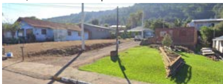
Figura 183: Quadra 3 - Vista da Esq. Rua Olavo Bilac e Rua Sem Identificação.
