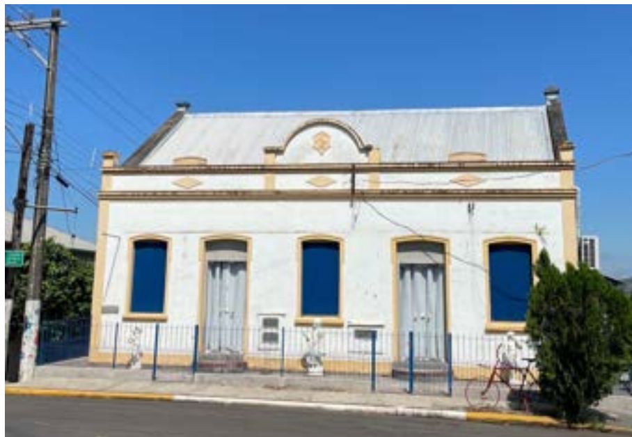
Figura 137: Edificação localizada na Rua General Osório.
