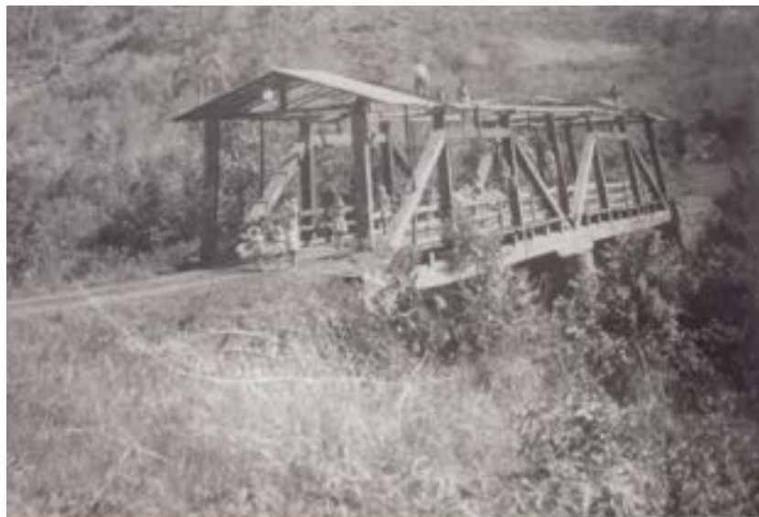
Figura 118: Primeira ponte sobre o Arroio Pagé, estrada que liga à Estrela pela ERS-129.
