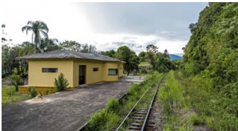
Figura 133: Estação ferroviária Corvo de Colinas.
