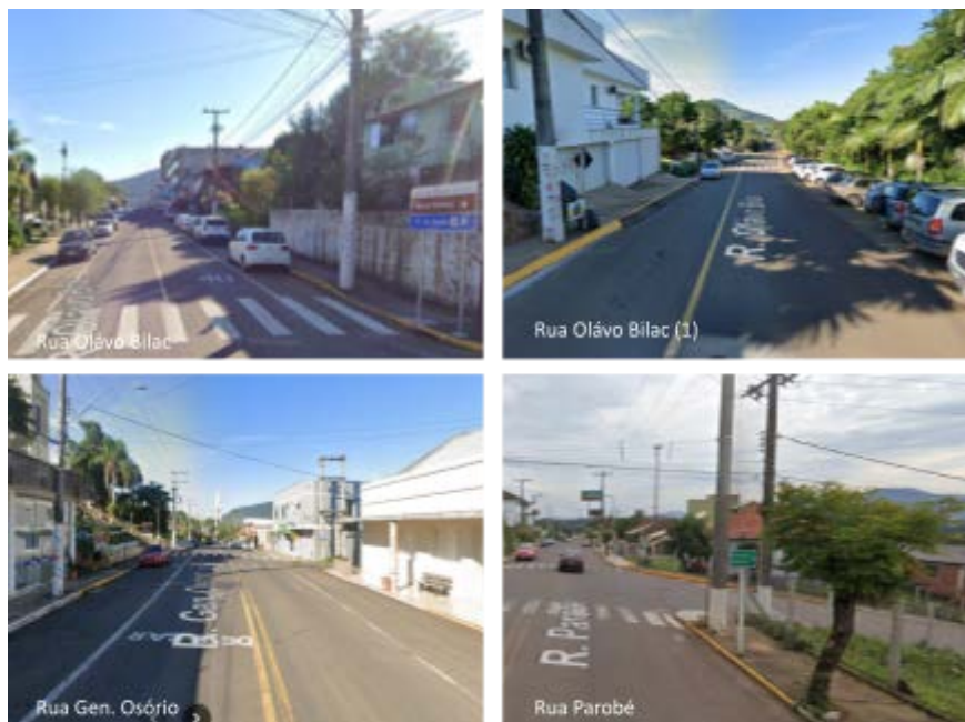
Figura 256: Condições atuais das calçadas da área da sede Municipal de Colinas.
