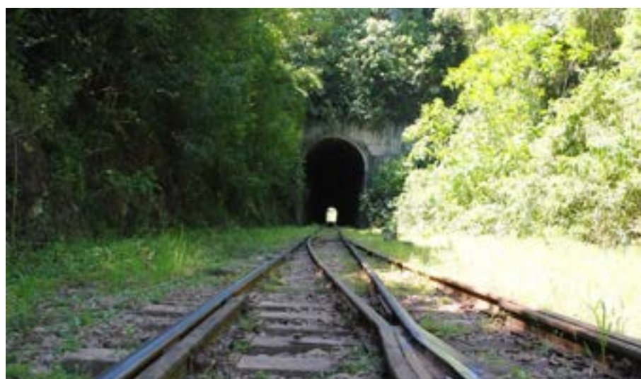
Figura 134: Túnel Ferroviário de Colinas.
