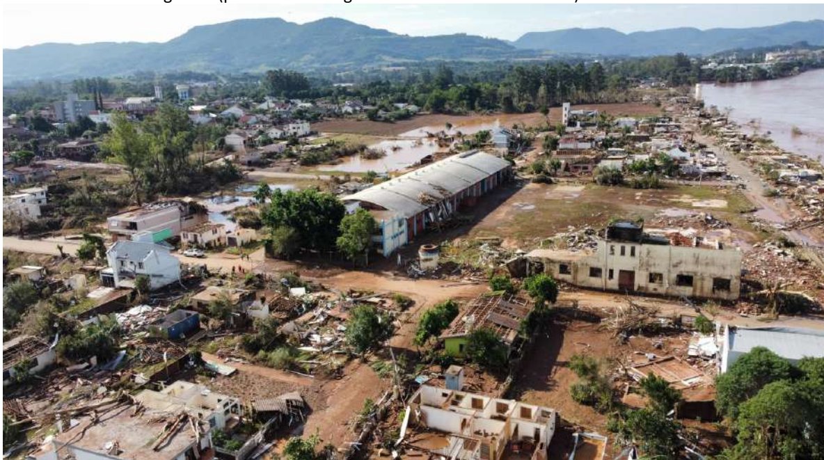
Figura 21: Área afetada pela enchente em maio de 2024, Rua Dr. João Carlos Machado, Bairro Navegantes (pavilhão da antiga Indústria de Balas Wallérius) - Arroio do Meio
