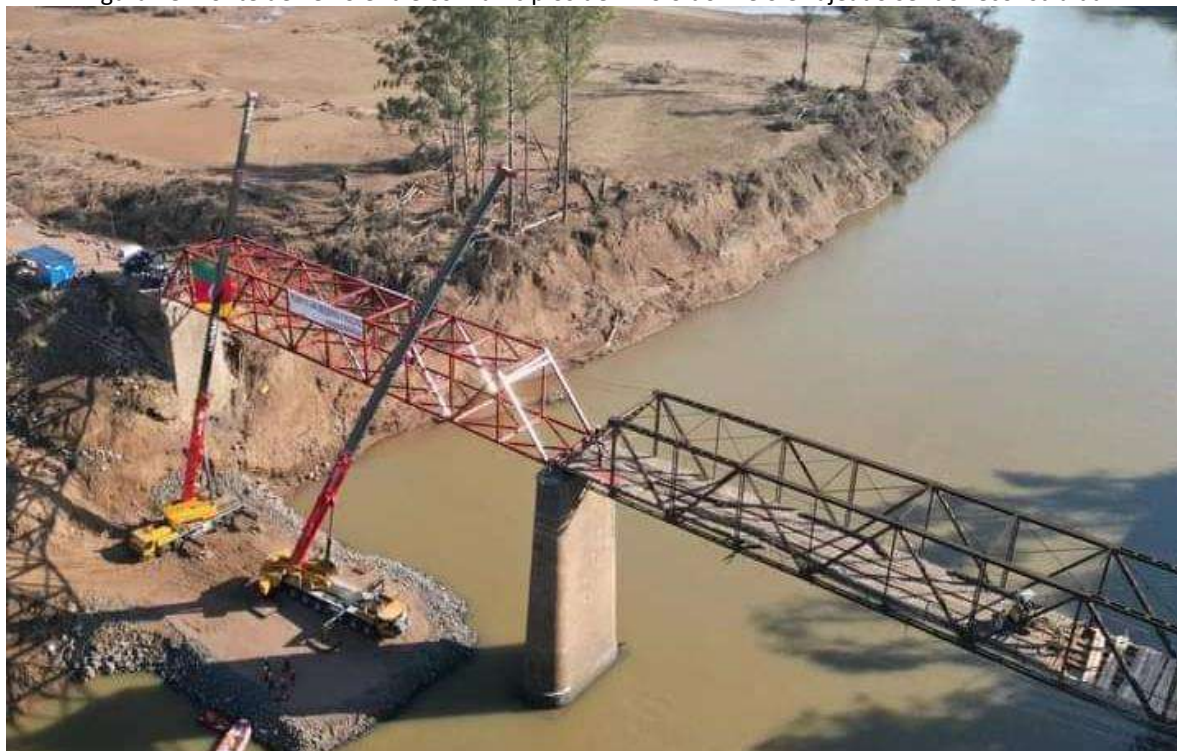
Figura 18: Ponte de Ferro entre os municípios de Arroio do Meio e Lajeado sendo reconstruída.
